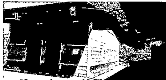
Foto 4: Mantenimiento a estructura (lijado, cambio de tubo, cepillado, sujeciones, y aplicación de pintura) de servicios sanitarios
