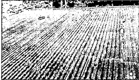
Foto 1: Sustitución de lamina por lámina troquelada calibre 26
